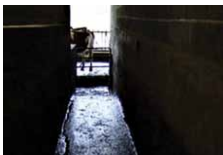
Zone d'ombre Couloir : 37 lux
