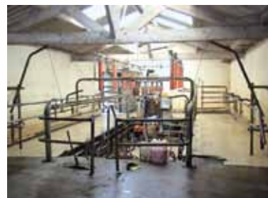
Salle de traite lumineuse avec translucides
