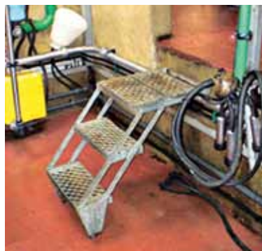
Escaliers avec une profondeur de marches différente.
