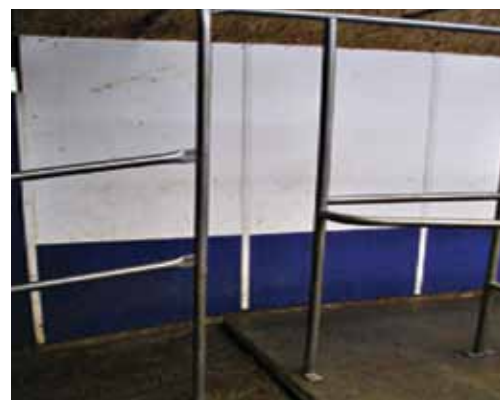
Dimension : 35 cm utiles entre les poteaux
