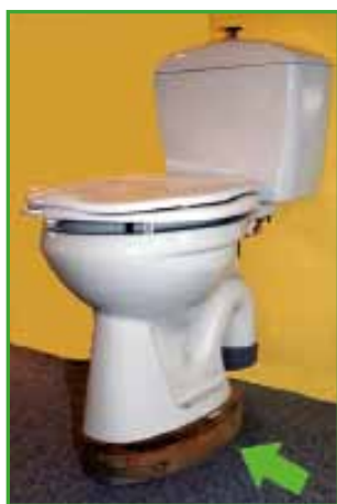
Rehausse placée sous le wc
