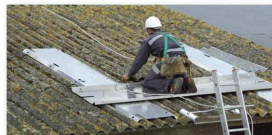
3 Deux planchers sont posés en parallèle sur le toit. Un troisième plancher est posé perpendiculairement sur les deux autres. L'intervenant dispose d'un chemin en U entourant la zone d'intervention
