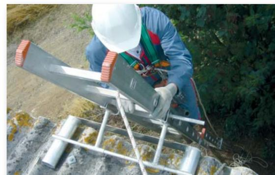
1 L'échelle doit dépasser la toiture de un mètre, elle est munie d'un stabilisateur
