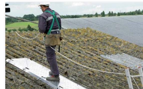
2 Les planchers permettent d'évoluer sur la toiture. Ils doivent toujours porter au moins sur 2 pannes
